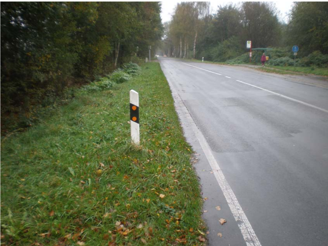
Odamm in Richtung Bushaltestelle. Bushaltestelle hinter dem „Blitzer“
